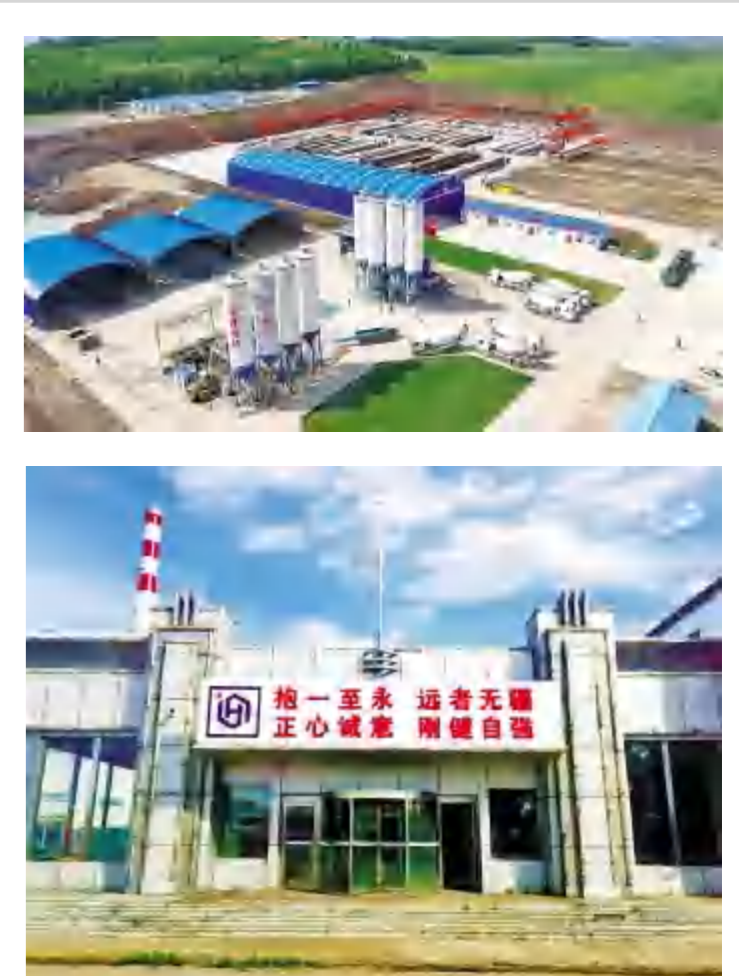
龙建三公司集集至当壁公路宝山至玉清段改扩建工程B标段项目
